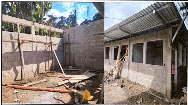
Foto 1: Seguimiento de pared, colocación de piso y repello de paredes en aula, dirección y baño.
