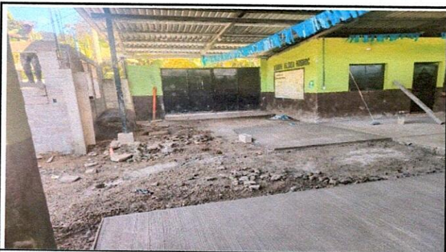
Foto 4: Reparación de piso de torta de concreto de la entrada del establecimiento.
