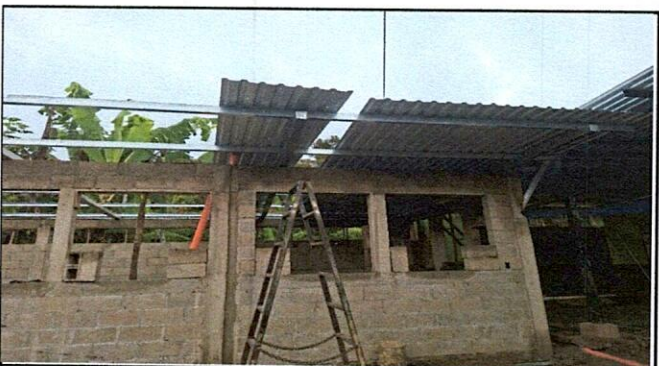
Foto 3: Colocación de entechado de modulo de un aula, dirección y baño.
